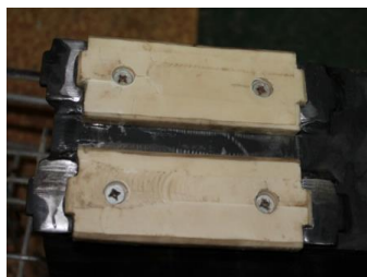
Рис. 1. Установка плит скольжения [1]
